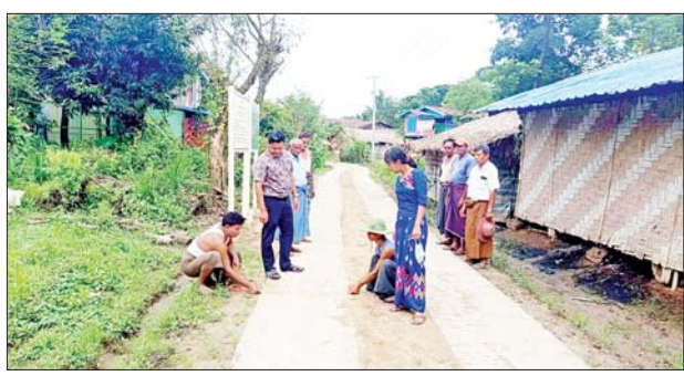
နိုင်ငံထွန်း၊ ကျောက်တံခါးမြို့နယ် ကျေးလက်ဒေသ ဖွံ့ဖြိုးတိုးတက် ရေးဦးစီးဌာန မြို့နယ်ဦးစီးမှူး ဒေါ်ပိုးအိဖြူကိုနှင့် ဝန်ထမ်းများက ဆူးပဒါးကျေးရွာ၌ ကျေးရွာတွင်း လမ်း ကွန်ကရစ်လမ်းခင်းခြင်း လုပ်ငန်းနှင့် ဆိုလာစွမ်းအင်သုံး ရေသန့်စင်စက် တပ်ဆင်ခြင်း လုပ်ငန်း ဆောင်ရွက်ပြီးစီးမှုအခြေ အနေများကို ကြည့်ရှုစစ်ဆေးသည်။ အဆိုပါ ကျေးရွာတွင်းလမ်း သည် အရှည်ပေ ၆၀၀၊ အကျယ်
