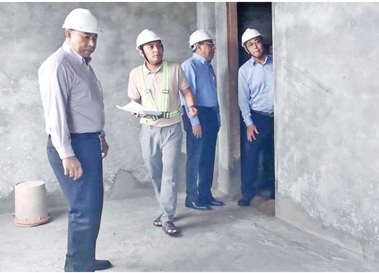
နှင့် အခြားဆက်စပ်လုပ်ငန်းများ (Roof Slab လုပ်ငန်းများပါဝင်မည်ဖြစ်ကြောင်း သိရနှင့် Extension Roof ) တည်ဆောက်ခြင်း သည်။ တိုင်းဒေသကြီး(ပြန်/ဆက်)
