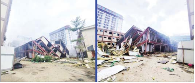
ကရင်ပြည်နယ် မြဝတီမြို့နယ် ရွှေကုက္ကိုလ်နယ်မြေရှိ အွန်လိုင်းလိမ်လည်လောင်းကစားမှု လုပ်ကိုင်ခဲ့ သည့် တရားမဝင် ခုနစ်ထပ်လူနေအဆောက်အအုံအား ယမ်းဖြင့်ဖောက်ခွဲဖျက်ဆီးပြီးမှုကို တွေ့ရစဉ်။
